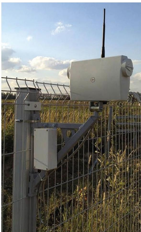
В качестве основного средства охраны периметра используется радиоволновый извещатель ДПР-200, имеющий очень узкую зону обнаружения.
